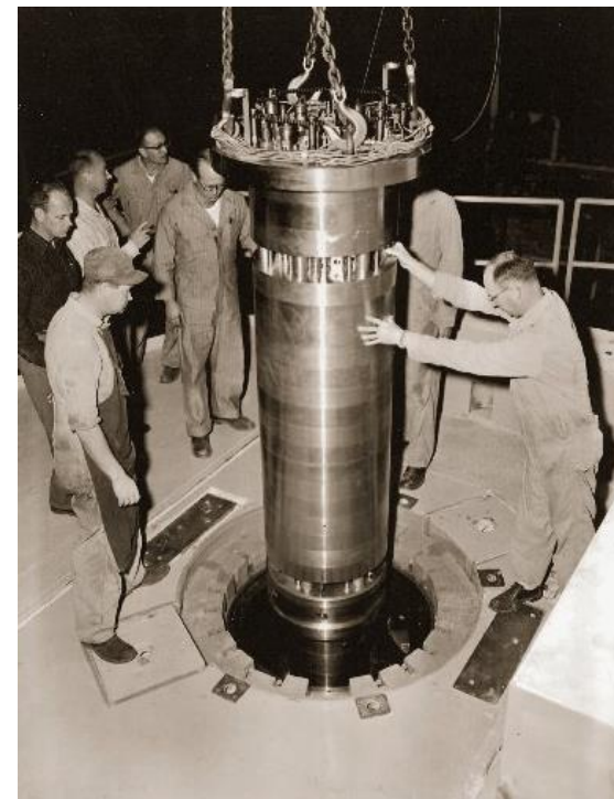
Inštalácia reaktorovej nádoby.
